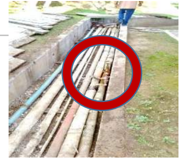
Tubería de vapor CISEI (después)
